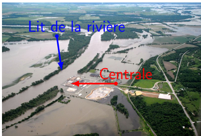
Inondation à la centrale nucléaire de Fort Calhoun (USA) en juin 2011.
